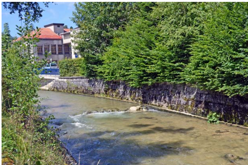
L'installation de quelques rochers permet de modifier le débit et la profondeur du cours d'eau. Ici entre le garage Balmer et la tour Bechler.
