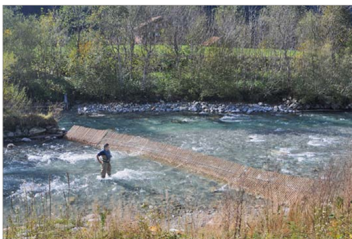
Abb.3: Die installierte Seeforellenweiche (Foto M. Meyer, KWO)
